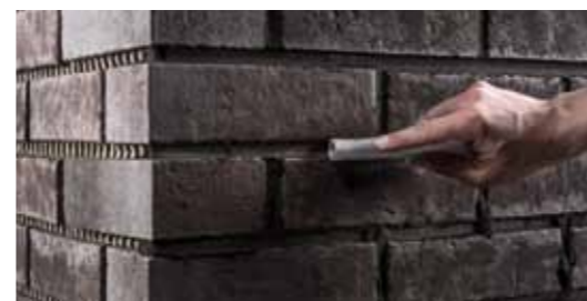
При расшивке швов кельмой можно выработать различные оптические элементы. Будь-то заглубленная затирка или шов, выполненный кельмой, который, как в данном случае, легко вжимается или вытягивается с помощью шланга.
