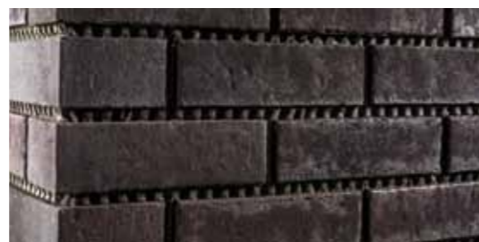
Полностью облицованная поверхность. После времени выдержки можно приступать к расшивке швов.
