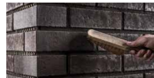
Обметание шва при помощи щетки придает ему соответствующую структуру.
