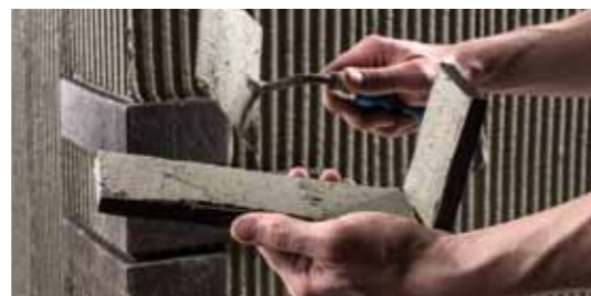
С уголками работают по методу двойного намазывания.
