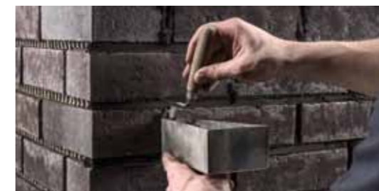
Вертикальные швы проще расшиваются с помощью шпателя меньших размеров для расшивки швов.
